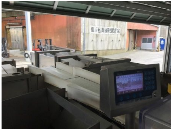
(重量選別機の全容・体)
