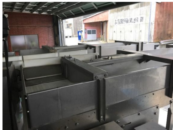
(選別槽。外気を入れているが、必要に応じてシャッターを下ろして操業)
